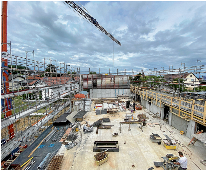
Die Außenwände der Sporthalle werden geschalt, die Bewehrung eingebaut und betoniert. Zu sehen: der obere Teil der Nordseite.
