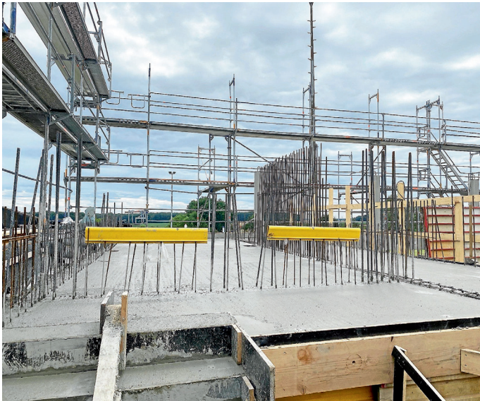
Die Decke über dem Erdgeschoss mit Sportgeräte Räume, Regieraum und Übungsleiterumkleide ist betoniert.
