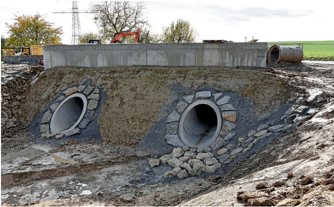
Modellierung und Fassung des Überlaufbauwerks und Kanalrohre
